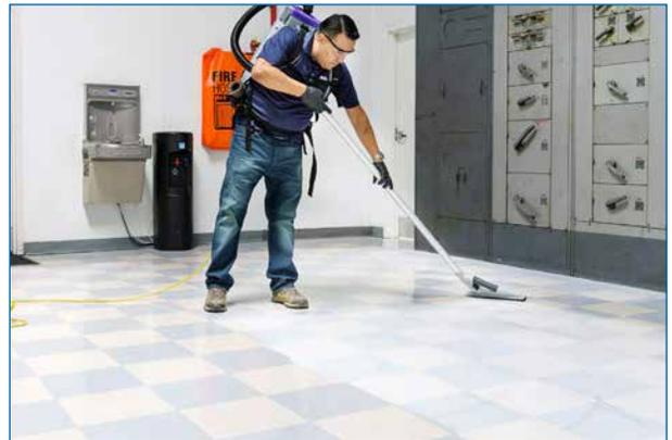
**5** Si la máquina no contiene control de polvo a bordo, aspire completamente el residuo y todo el polvo con una aspiradora de espalda vertical.
